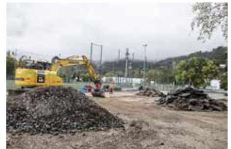
Lancement de la construction du Pumptrack .
