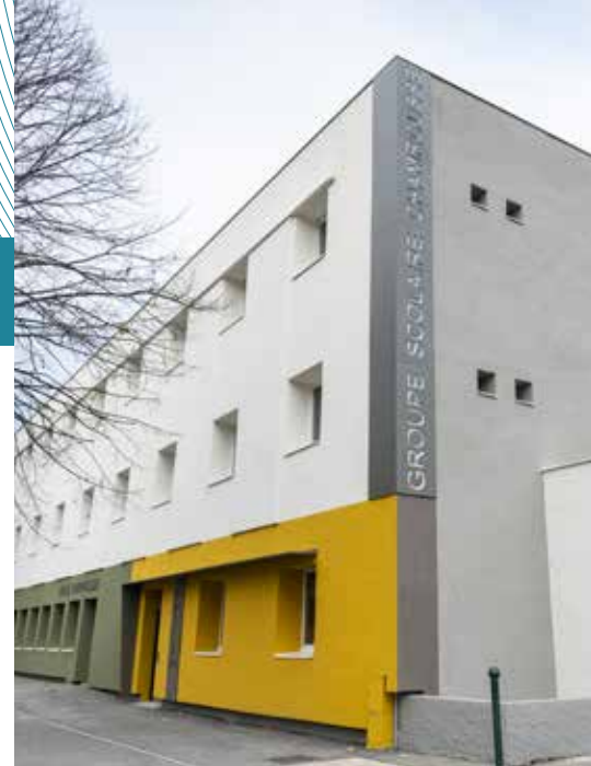
Rénovation thermique et amélioration de l'efficacité énergétique de l'école élémentaire Chamrousse.
